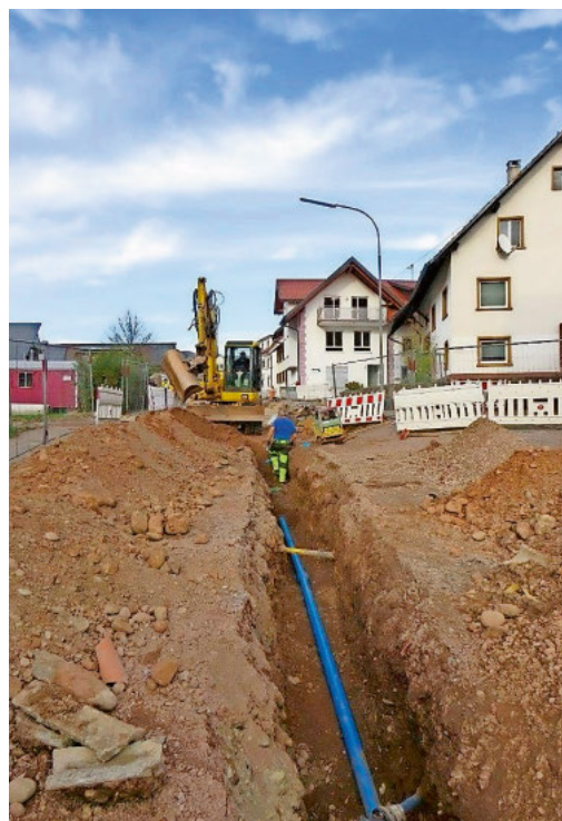
Die neue Wasserleitung wird verlegt
