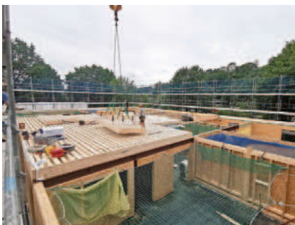
Errichtung des Rohbaus in Holzbauweise
