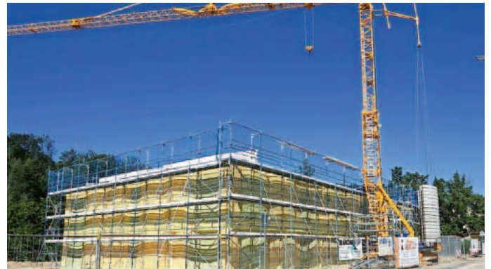
Die vor Witterungseinflüssen geschützte Fassade
