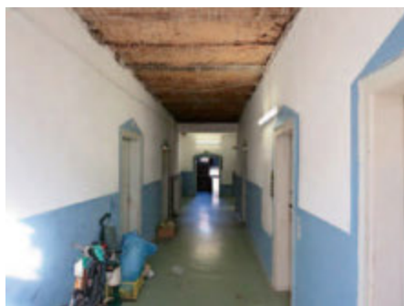
Innenansicht des Altbaus
